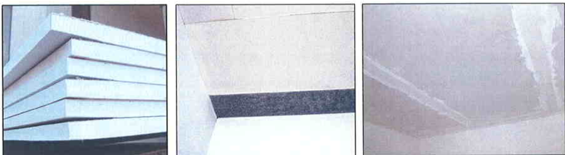
Imágenes 6, 7 y 8 Placas de yeso laminado y su encolado sobre el panel
