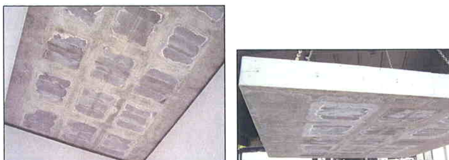
Imágenes 3 y 4 Forjado de hormigón armado
